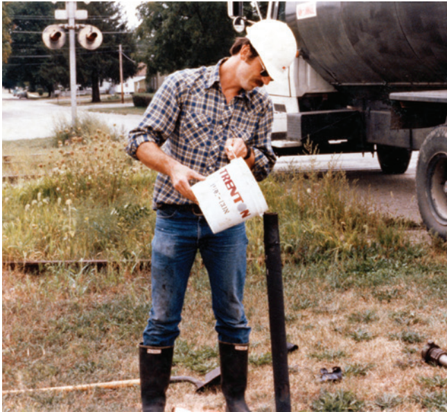
Le Pre-Con® est versé dans la gaine par le système d'aération
